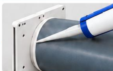
Application d'un joint silicone sur tout le pourtour
